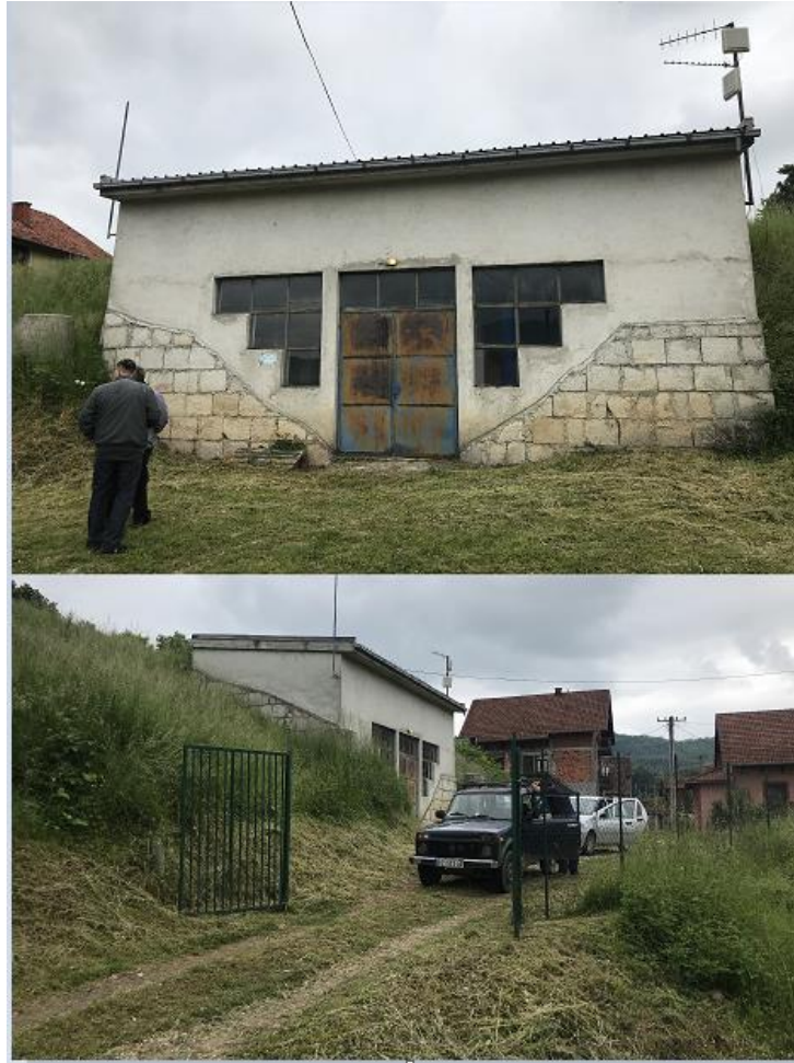
Слика. 13. Резервоар P1
