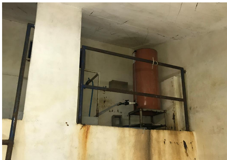
Слика. 25. Хлорисање воде на изворишту Клокоч
