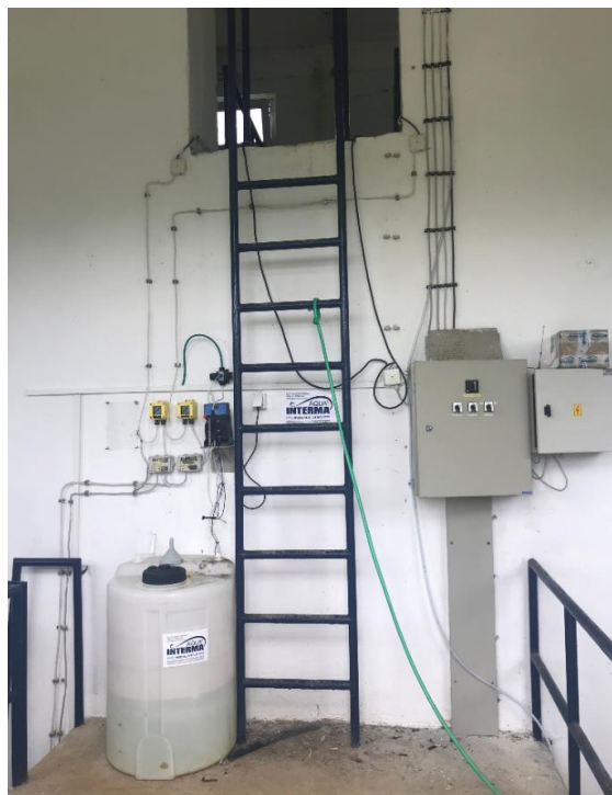
Слика. 22. Хлорисање воде у резервоару Р2
