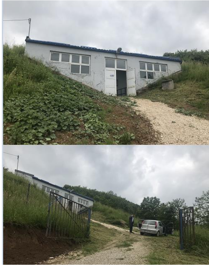
Слика.21. Резервоар Р2
